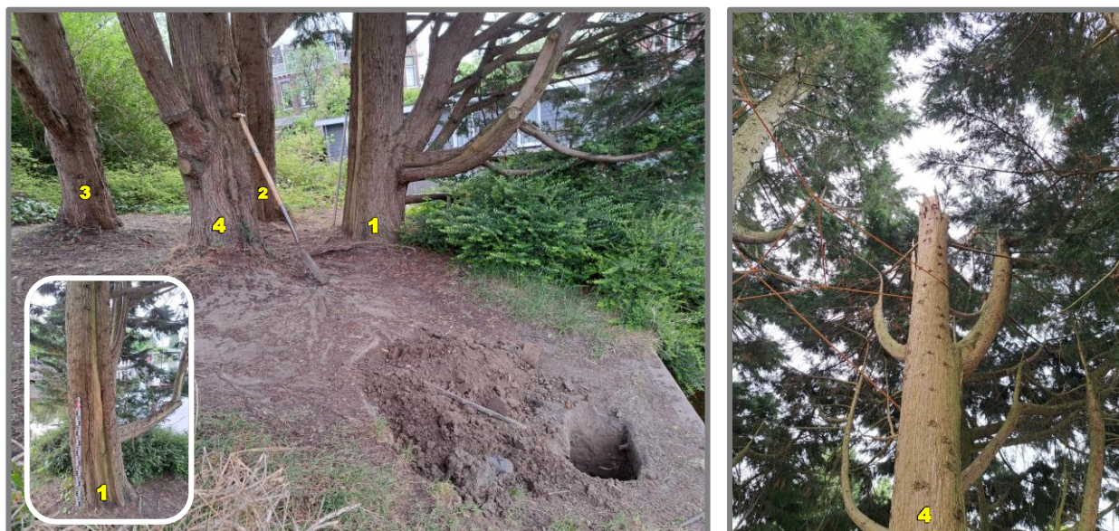
Fig. 1: Hoewel vanaf een afstand het één brede conifeer lijkt, bestaat de beplanting uit vier individuele bomen. Alle vier bomen hebben beschadigingen aan de stam (inzet links) en bij de boom aan de windzijde is de top uitgebroken.
