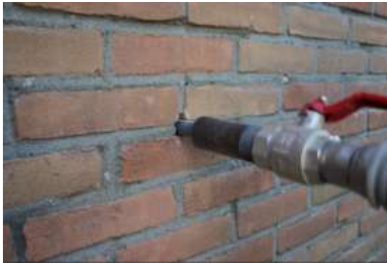
Spouwmuurisolatie
