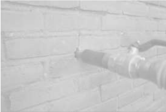
Spouwmuurisolatie
