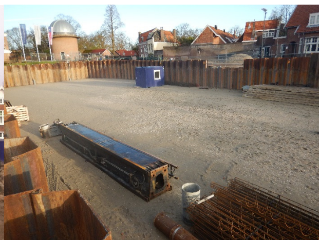
Afbeelding 2 Bouwput stadswoningen gereed
