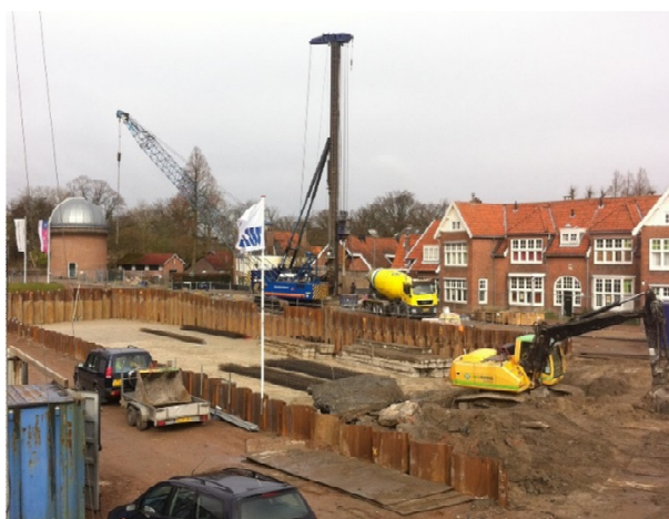
Afbeelding 1 Uitvoering grondverdringende boorpalen cottagewoningen
