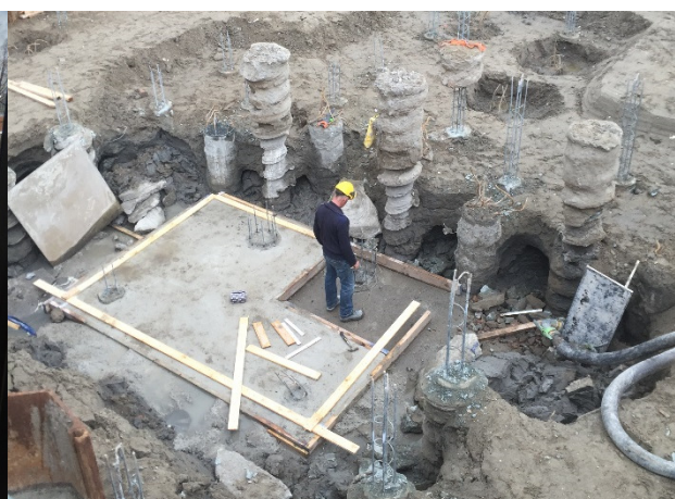
Afbeelding 4 Uitvoering liftput woontoren
